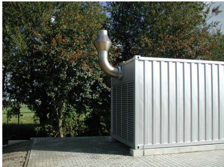
Detaillösung Deflektorhaube aus Eigenfertigung
